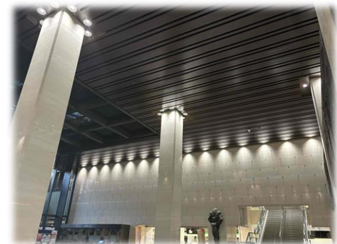
本庁舎1階市民ロビー照明のLED化
