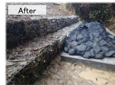
池田谷川 (ふとんかご設置等により通水断面を確保)
