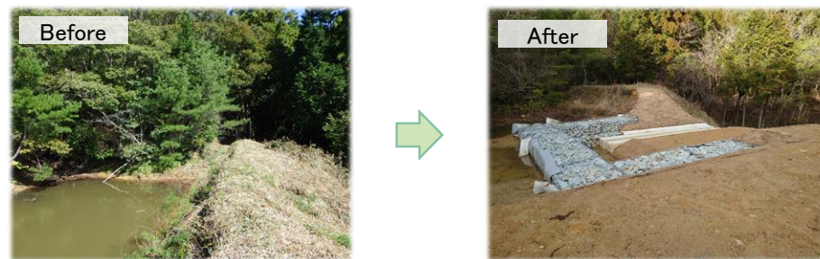
農業用ため池の廃止工事(西脇市谷町 山田池)
