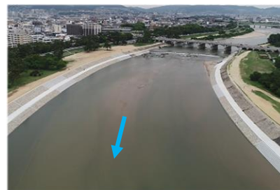
武庫川 護岸工事(尼崎市・西宮市)
