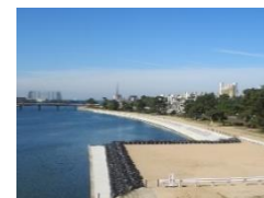
治水対策の推進(河川改修)
