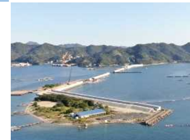
福良港 湾口防波堤
