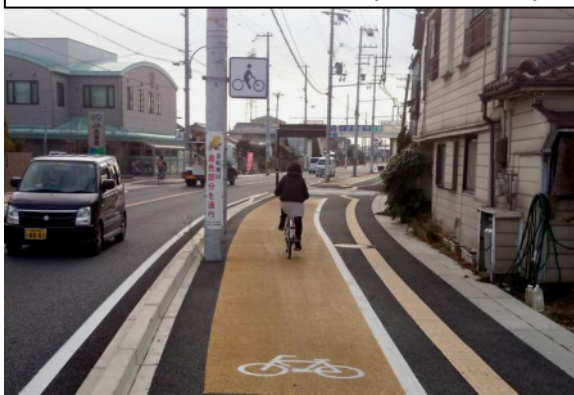
対策 歩道上のカラー舗装(明石高砂線)
