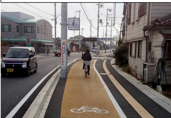
対策①歩道上のカラー舗装（明石高砂線）
