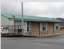
多目的倉庫、交流広場
