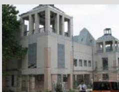
斜行EV上部ステーション2階ホール
