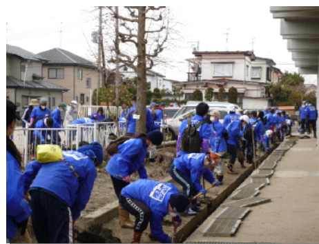
学校校庭の側溝の泥だし
