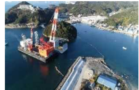
福良港湾口防波堤
