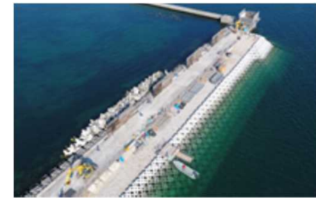
福良港湾口防波堤整備
