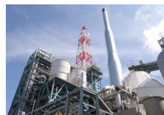
木質バイオマス発電施設 (株日本海水 赤穂工場)
