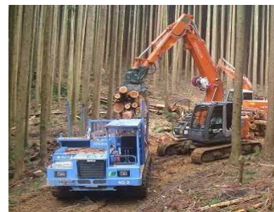
高性能林業機械を扱う現場 技術者の育成状況(宍粟市)
