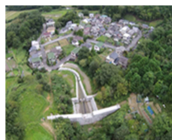
砂防えん堤(猪名川町)
