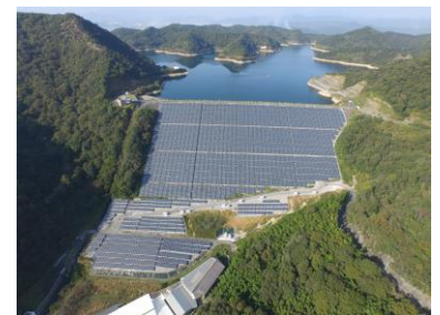
神谷ダム太陽光発電所
