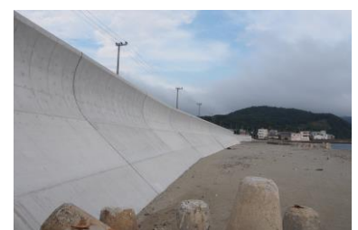
阿万港海岸における防潮堤の整備
