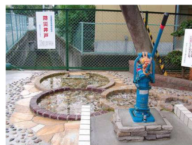
マンションに設置された防災井戸(加古川)
