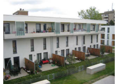
高層住宅から建て替えられた住宅(ドイツ)
