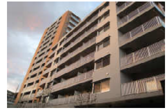
学生が混住する高齢者施設(神戸)
