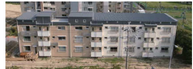
5階建て集合住宅の上層2階を減築した団地
