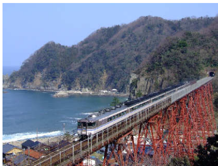
余部鉄橋（撤去前）
