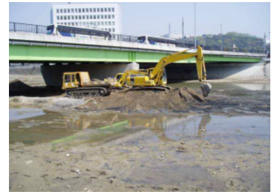
河川の堆積土砂の除去
