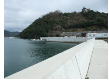
防潮堤の整備状況（南あわじ福良港）
