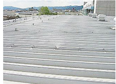
倉庫屋根への散水状況（イメージ）
