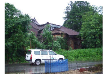
倒壊した空き家(豊岡市)
