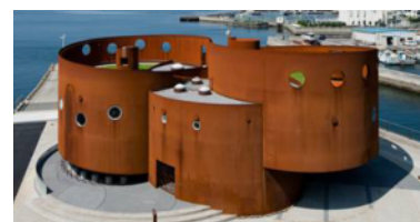
津波と防災を「知る」「逃げる」「備える」体験館、福良港津波防災ステーション（南あわじ）
