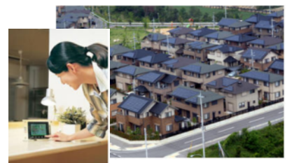
大規模な太陽光発電戸建住宅群と発電モニタによる「見える化」(神戸)
