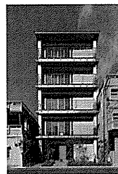
CLT(直交集成板)を活用した木造建築物
