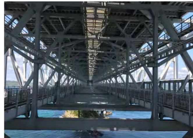
【大鳴門橋桁下空間】
