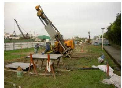
沈下対策の実施状況(尼崎市)
