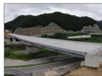
山陰近畿自動車道 浜坂道路 [施工中] (新温泉町)
