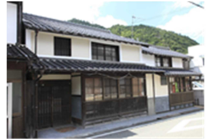
再生した古民家(朝来市)
