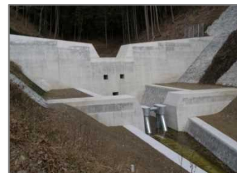
奥ノ谷川砂防えん堤（佐用町）
