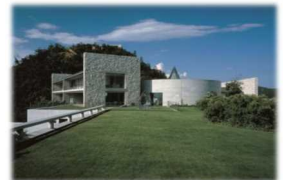
美術館と一体となった宿泊施設（直島）
