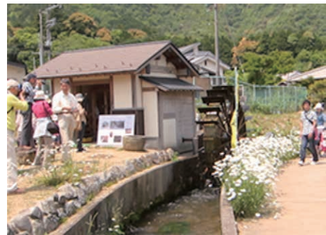
下掛水車による発電 (神河町)
