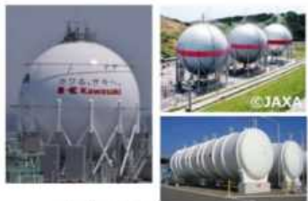
液化水素タンク
