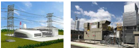
水素発電/コジェネ利用 (電気・熱利用者へのCN水素供給)
