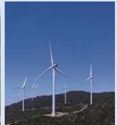
CEF南あわじwindファーム (南あわじ市)
