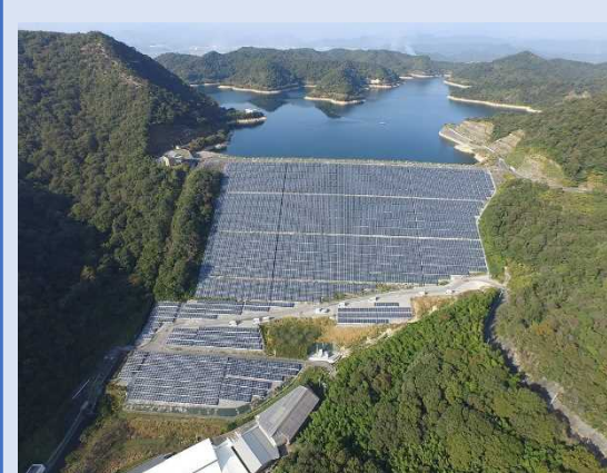
神谷 (コタ) ダム太陽光発電所 (姫路市)
