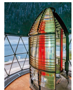
灯台ごとに光り方が異なり、江崎灯台では赤と白の光がレンズを通して5秒ずつ交互に放たれます。
