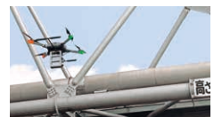
水管橋のエクسس線点検
