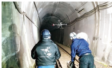
トンネル内の点検
