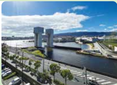
水害から街を守る新川水門の整備
