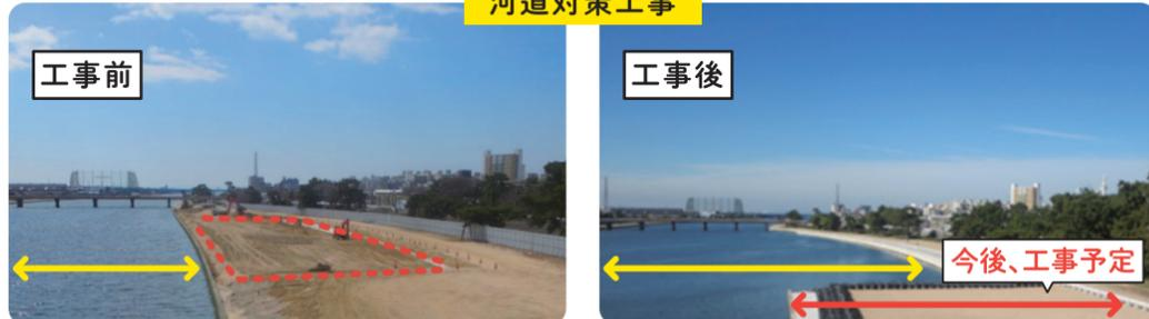
川の底を掘り下げたり川の幅を広げたりして、流れる水の量を増やしています。
