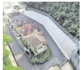
急傾斜地崩壊防止工事
