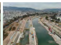
武庫川河床掘削・護岸整備
