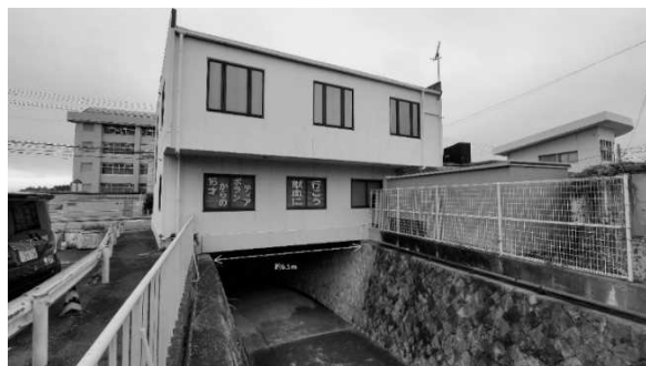
本ルームの地下通路
