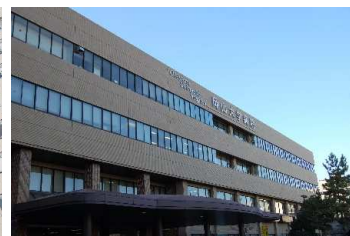
岡山大学病院外来棟
