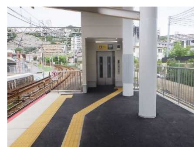
□鉄道駅におけるエレベーター設置
