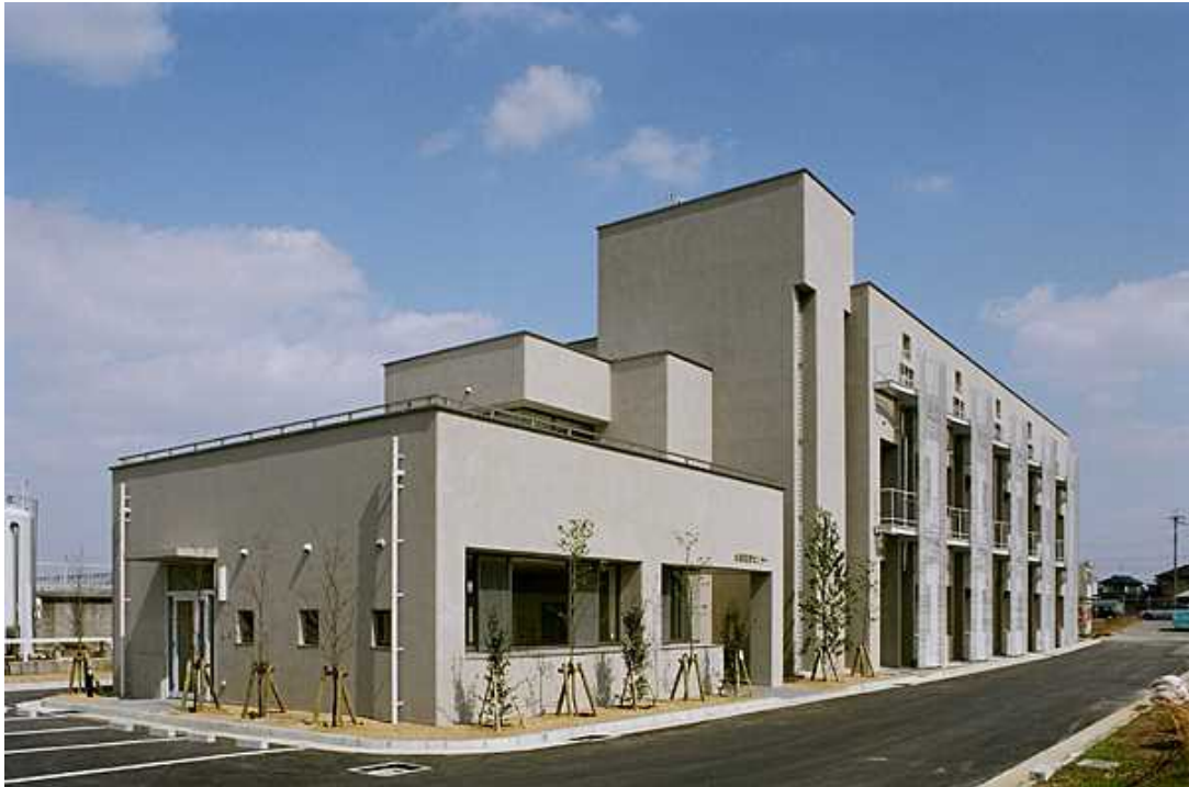
水質管理センター全景
