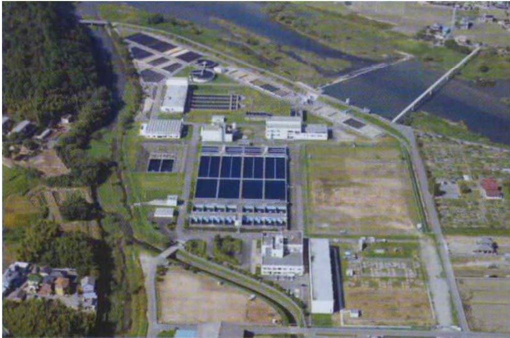
姫路利水事務所 (船津浄水場)
