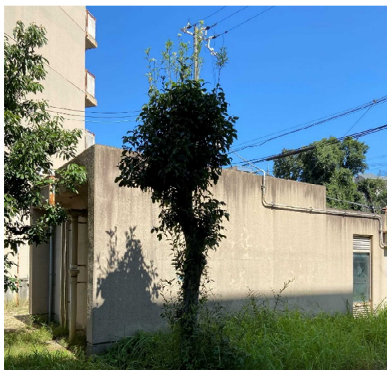
＜ポンプ室(新設分)＞
