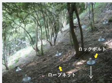
R・R併用法を施工した山腹斜面
