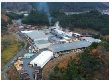
協同組合 兵庫木材センターの全景
