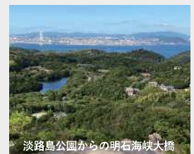
淡路島公園からの明石海峡大橋
