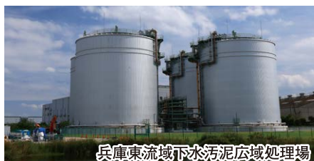
兵庫東流域下水汚泥広域処理場
