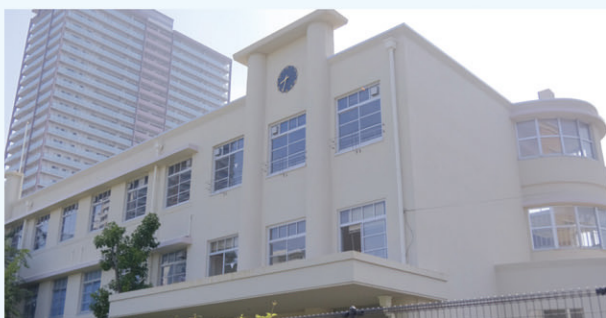
尼崎市役所開明庁舎(旧開明尋常小学校校舎)【尼崎市】
