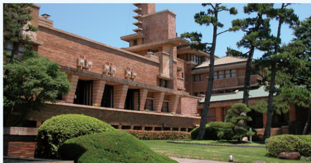
武庫川女子大学甲子園会館(旧甲子園ホテル)【西宮市】
