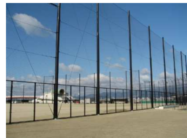
供用中の野球場（丸島地区）
