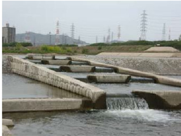
図 2-6 床止めに設置された魚道
