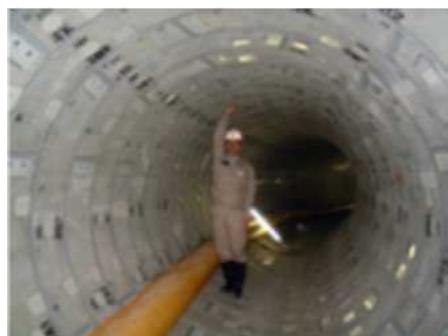
図5-6 雨水貯留管 (西宮市) (出典：西宮市下水道ビジョン)
