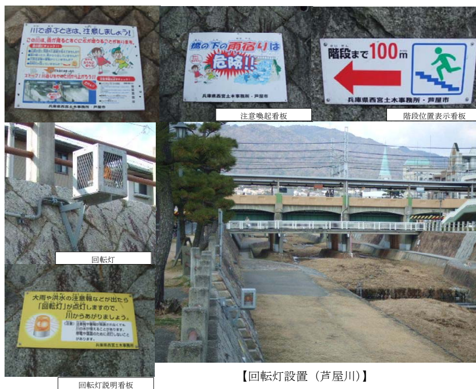
図 7-6 回転灯の設置
