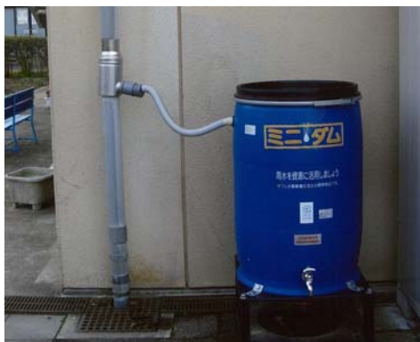
図 6-16 その他の雨水貯留・浸透の取り組み（左：雨水貯留タンク、右：浸透管・浸透枳）
