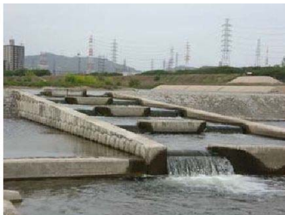
図 2-6 床止めに設置された魚道
