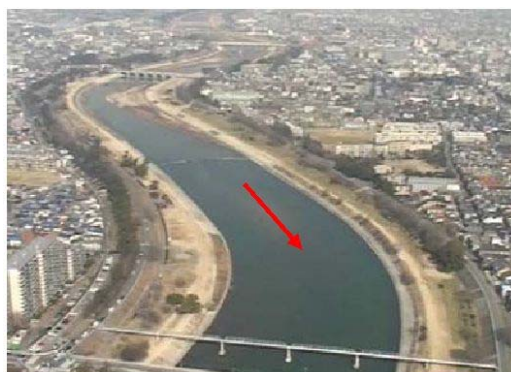
図 2-3 下流部築堤区間
