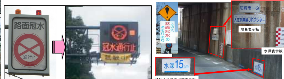
【字幕式→LED式冠水情報板】
