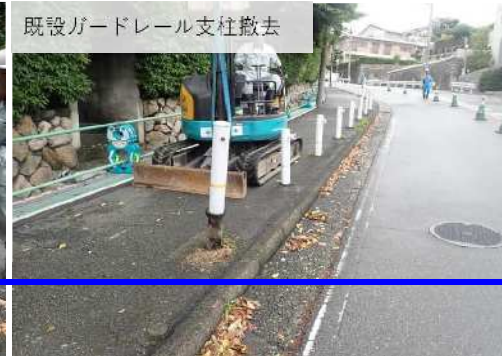
既設ガードレール支柱基礎撤去
