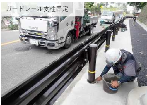
埋め戻し部締め締め
