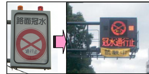
【字幕式 LED式冠水情報板】
