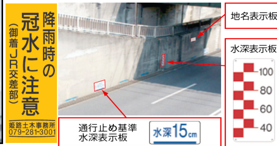
【注意喚起看板等の冠水対策】
