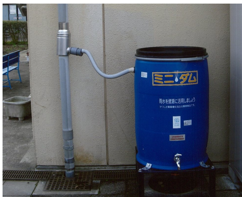
図 6-16 その他の雨水貯留・浸透の取り組み（左：雨水貯留タンク、右：浸透管・浸透柵）
